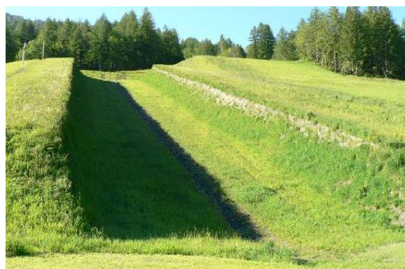
Prima (sinistra) e dopo (destra) interventi di inerbimento con idrosemina. Sopra: sponda fluviale.
