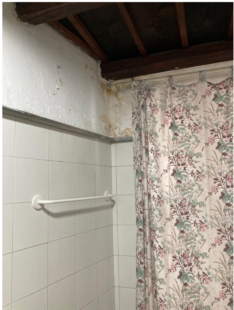
Bagni celle infiltrazioni
