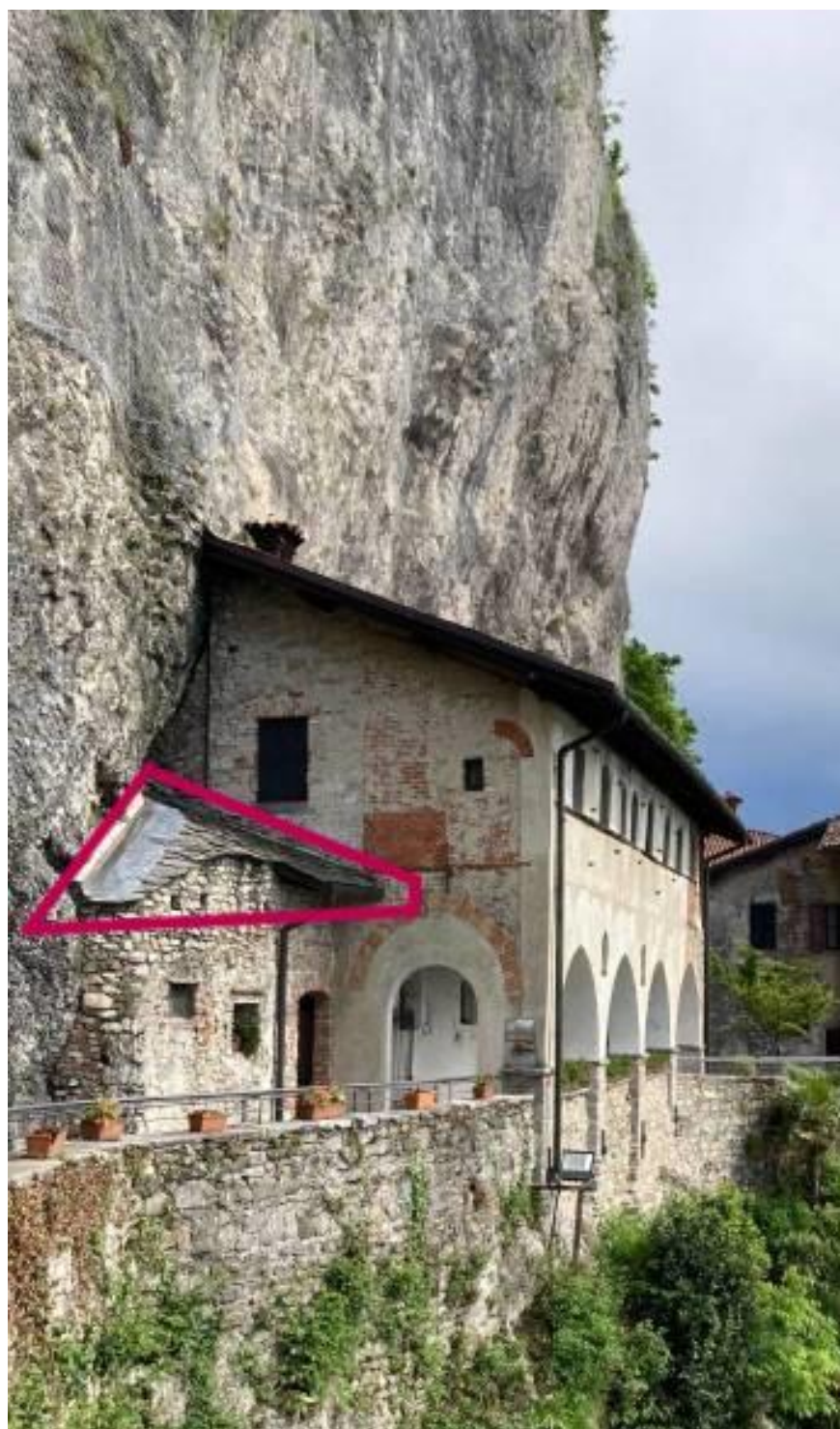
Cucina – area di intervento
