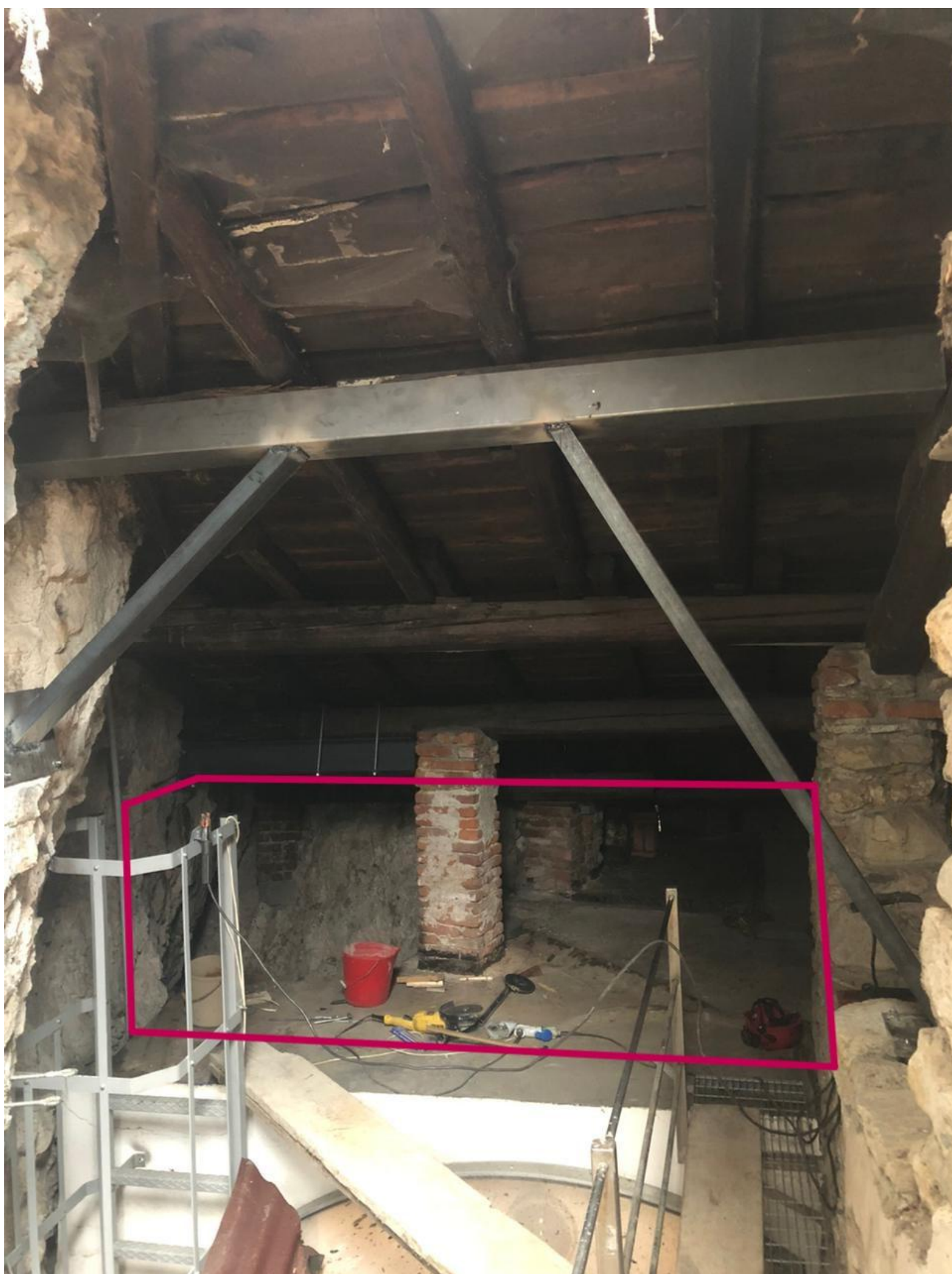
Bagni celle zona intervento nel sottotetto
